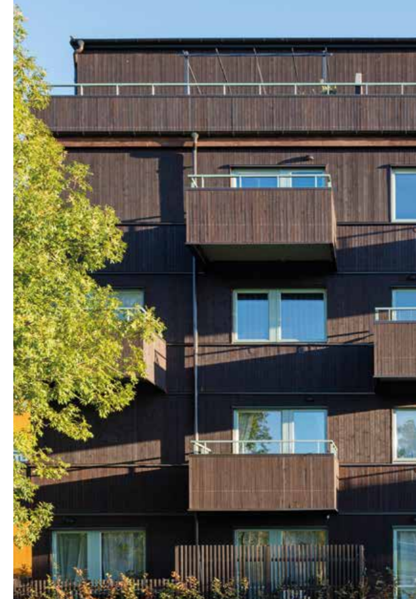
Projekt: 02 Orminge – Nybackakvarteren, Nacka Material: Brandskyddad och infärgad ThermoWood enligt SP Fire 105 Arkitekt: DinellJohansson
